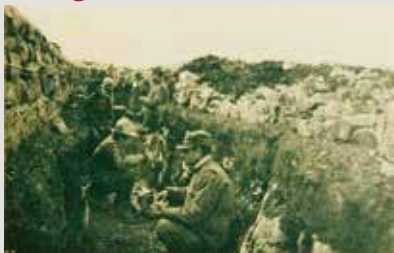
Trincee nella zona di Castelnuovo (Carso).
